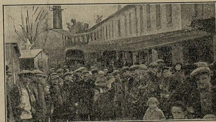
Vermicellerie. — Vue prise de l'entrée.
